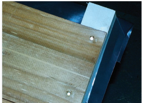
Figiúr 2: Is í tairneáil ag an bhfíorchiumhais an cás fosaithe is déine.
